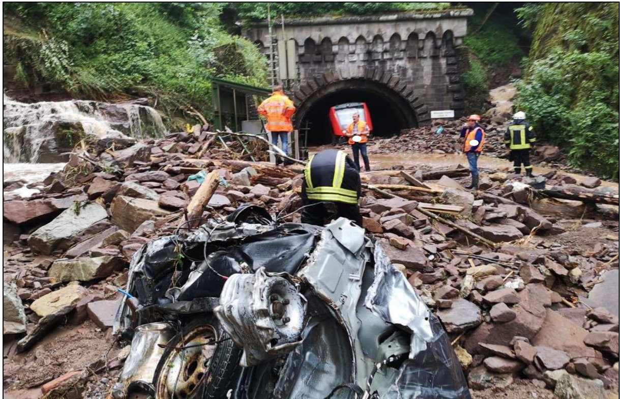
Abbildung 8: Entgleister Zug Wilsecker Tunnel
