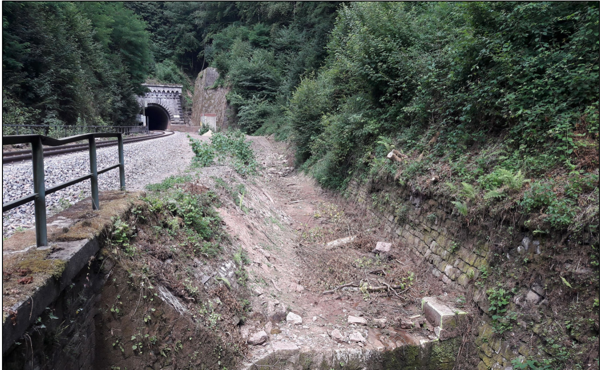
Abbildung 40: Grabenausbildung Schienengraben entlang der Bahngleise
