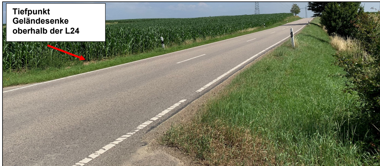
Abbildung 64: Tiefpunkt Geländesenke Grummeltergraben oberhalb der L 24
