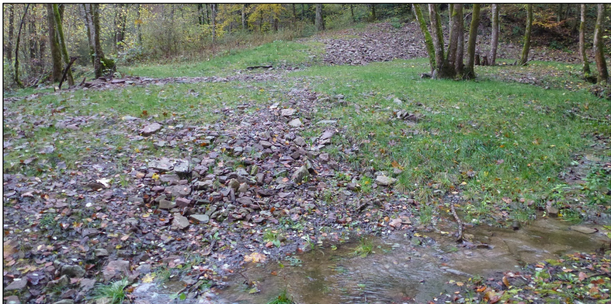
Abbildung 90: Mündungsbereich Wilsecker Bach / Kyll nach den Sofortmaßnahmen
