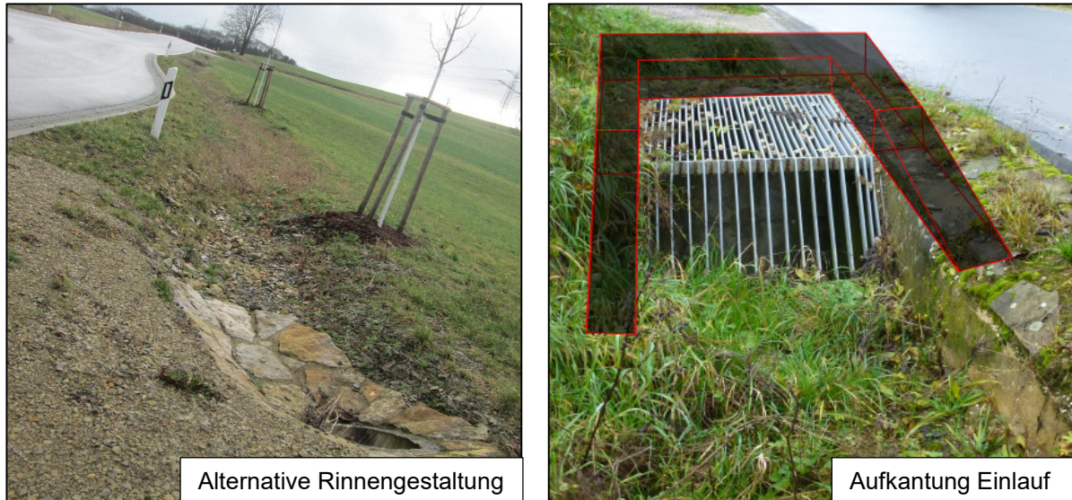
Abbildung 84: Anpassungen Straßenentwässerung und Einlaufbauwerk Bademer Straße
