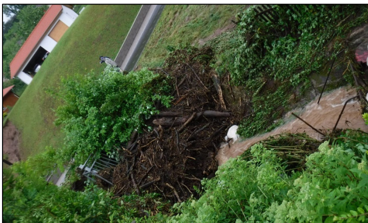
Abbildung 27: Ablagerungen Einlaufbauwerk Wilsecker Bach, Starkregenereignis 2018
