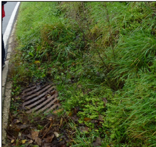
Abbildung 56: Straßeneinlauf Kyllburger Straße
