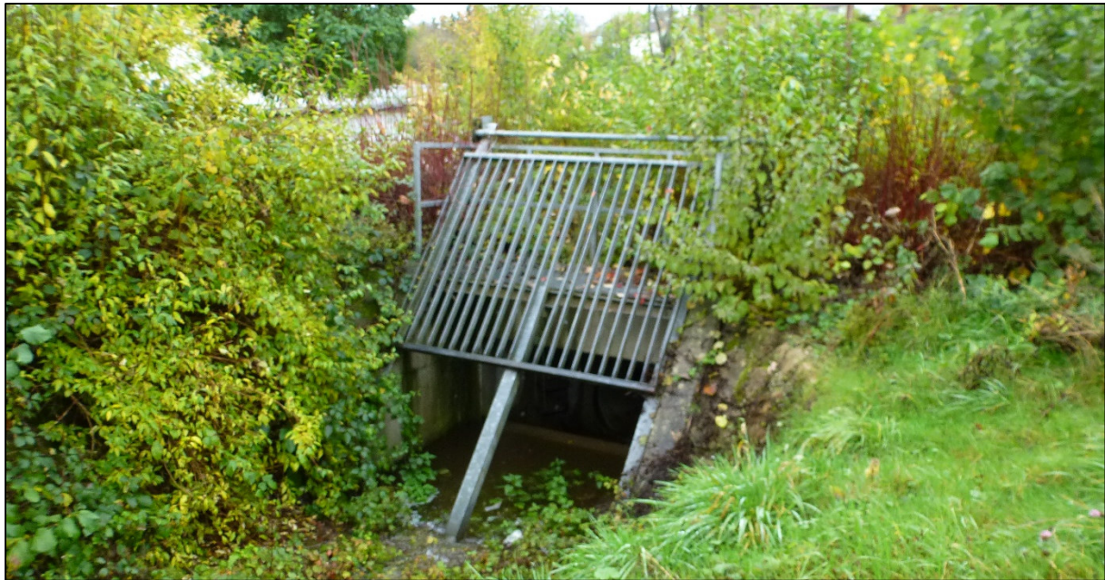
Abbildung 26: Einlaufbauwerk Verrohrung Wilsecker Bach
