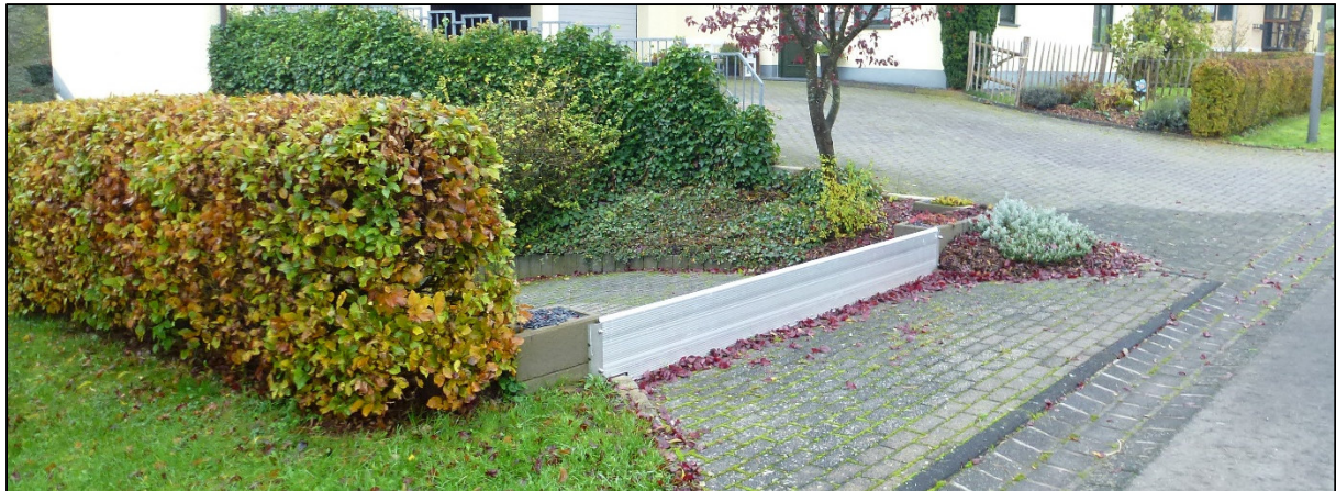
Abbildung 82: Beispiel Dammbalkensystem Einfahrt
