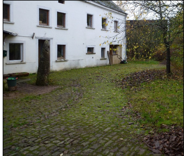
Abbildung 32: Außenbereich Gebäude Hsnr. 13
