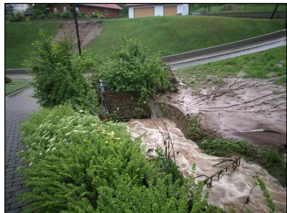
Abbildung 10: Einlaufbauwerk Wilsecker Bach
