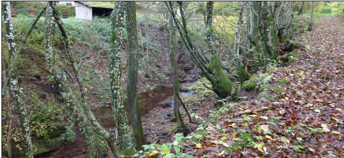
Abbildung 37: Schienengraben unterhalb der K 87
