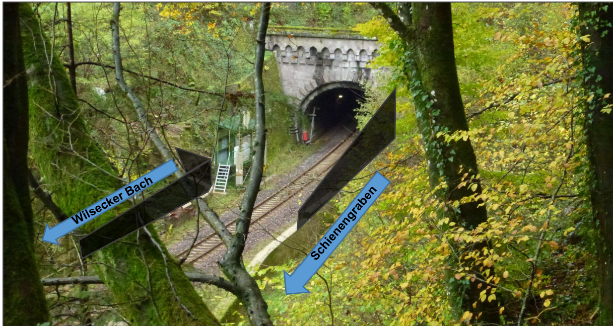
Abbildung 81: Anpassung Stützwände Wilsecker Tunnel
