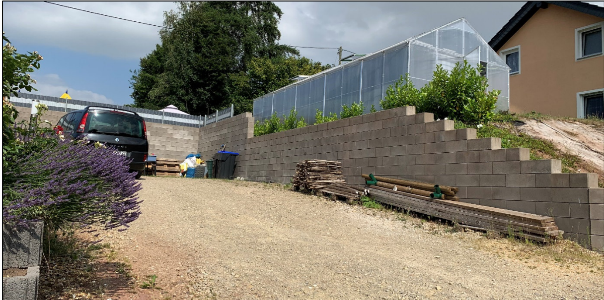
Abbildung 50: Mauer Bergstraße Hsnr. 11
