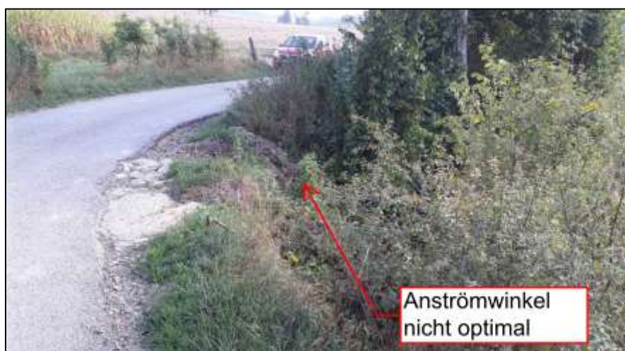
Abbildung 17: Durchlass Schanzbach Wirtschaftsweg
