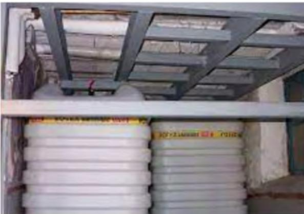
Abb. 10: Sicherung Heizöltanks (BMWSB 2022)
