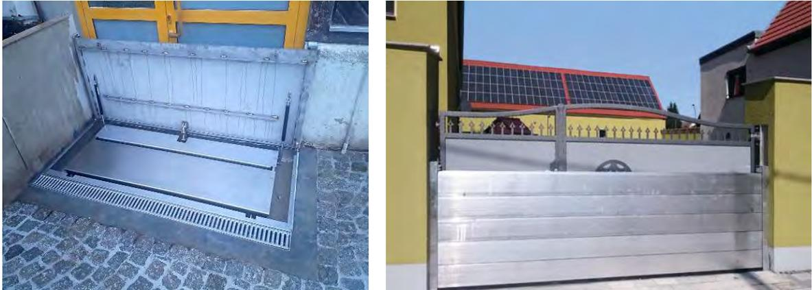
Abb. 9: Klappschotttor oder mobiles Dammbalkensystem an Hauseingängen (BMWSB 2022)
