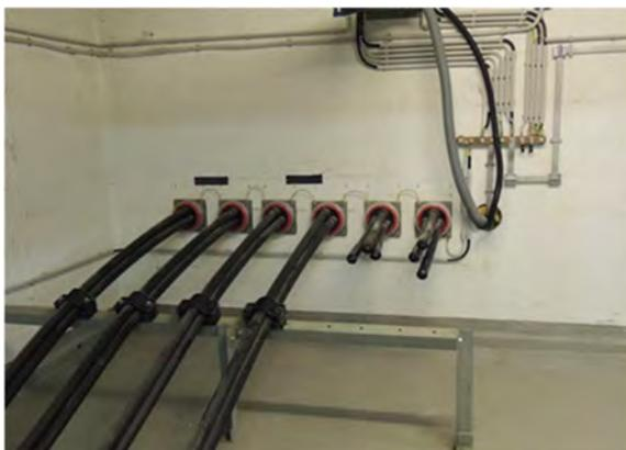
Die Durchführungen von Rohren durch die Kellerwand stellen Schwachstelle dar, die durch die Verwendung professioneller Mediendurchführung sicher abgedichtet werden können.
