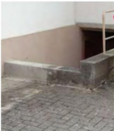
Der Kellerschacht wird durch Mauerwerk erhöht und damit eine Barriere für abfließendes Oberflächenwasser geschaffen.
