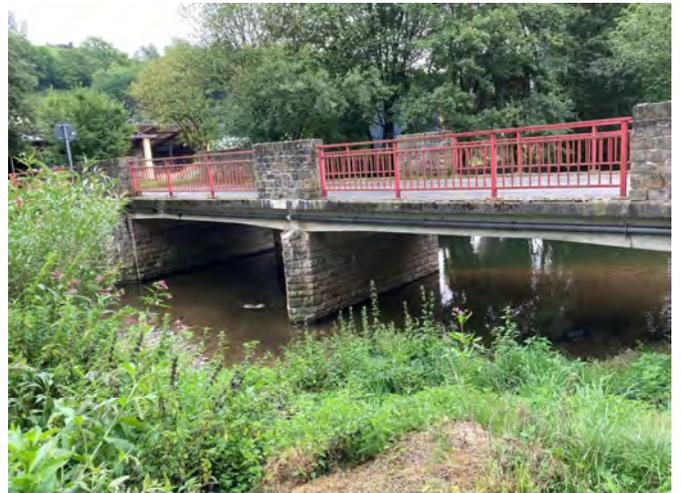
Abb. 65: Tiefenerosion und fehlende Unterhaltung an der Enz im Ortsinneren von Enzen und zweites. Brückenbauwerk mit gefährdeter Infrastruktur im Überschwemmungsbereich
