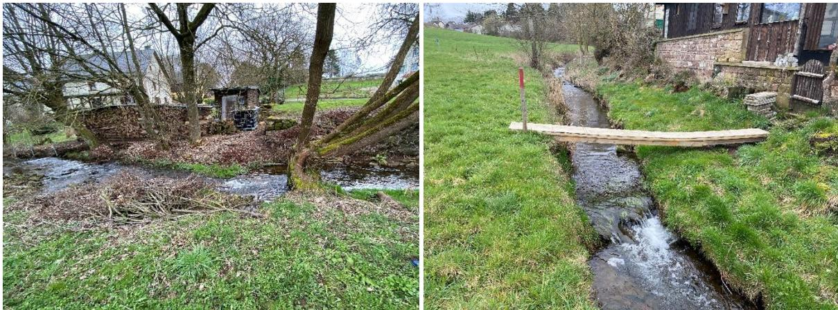
Abbildung 17: Lagerung von Schnittholz im Hochwasserabflussbereich (links) und Einengung des Gewässerquerschnittes durch private Fußgängerbrücke (rechts) im Bereich der Burgstraße.
