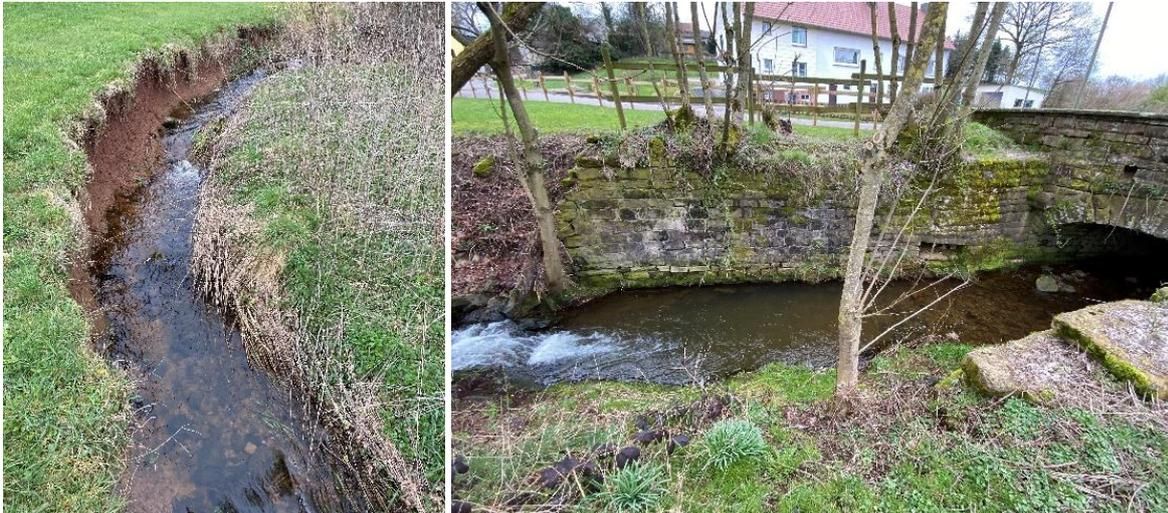
Abbildung 18: Eintiefung des Gewässerquerschnittes und Unterspülung des Brückenbauwerkes Kreuzung Brunnenstraße/ Bergstraße
