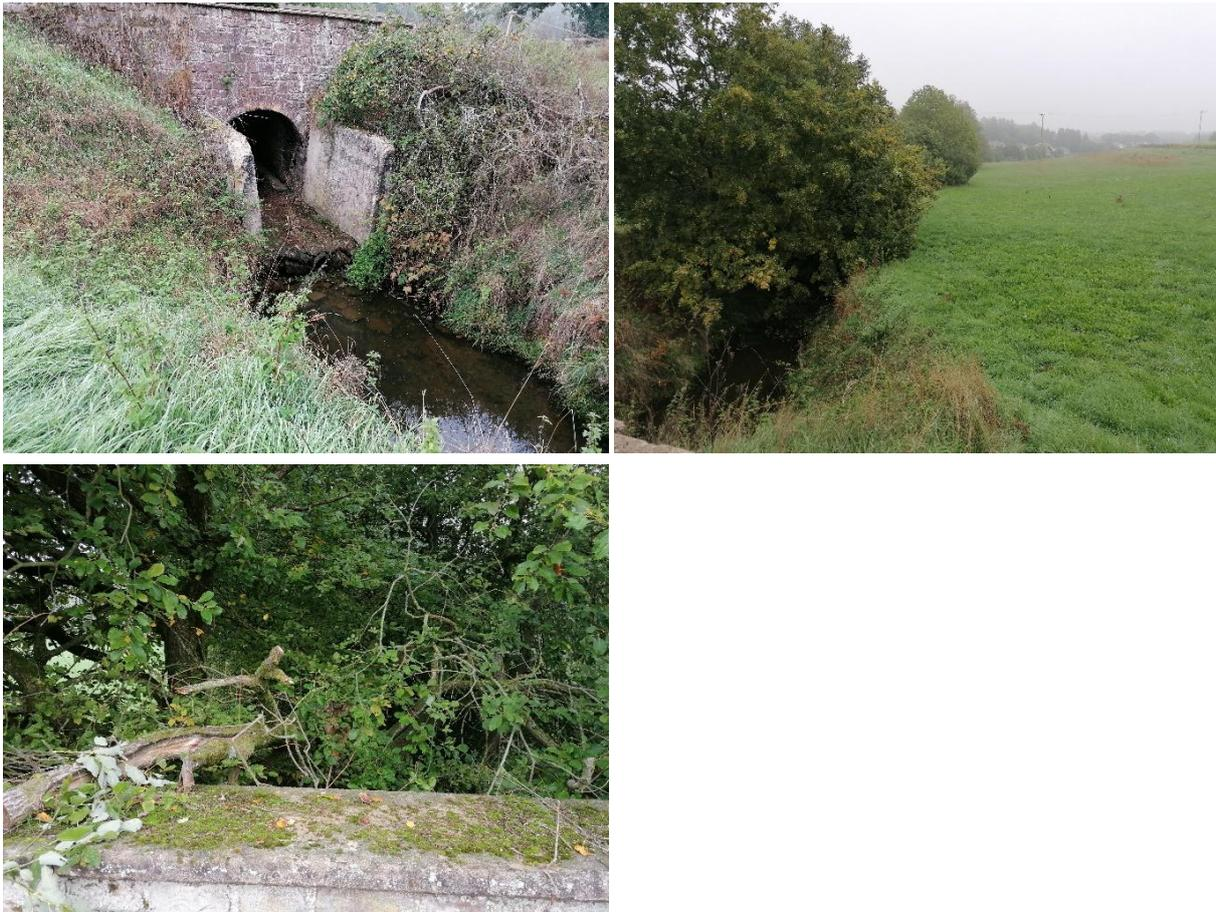
Abbildung 14: Brückenbauwerk am Kailbach südlich der Burg Seinsfeld mit Darstellung von losem Astwerk im Gewässerquerschnitt unterhalb der Brücke.
