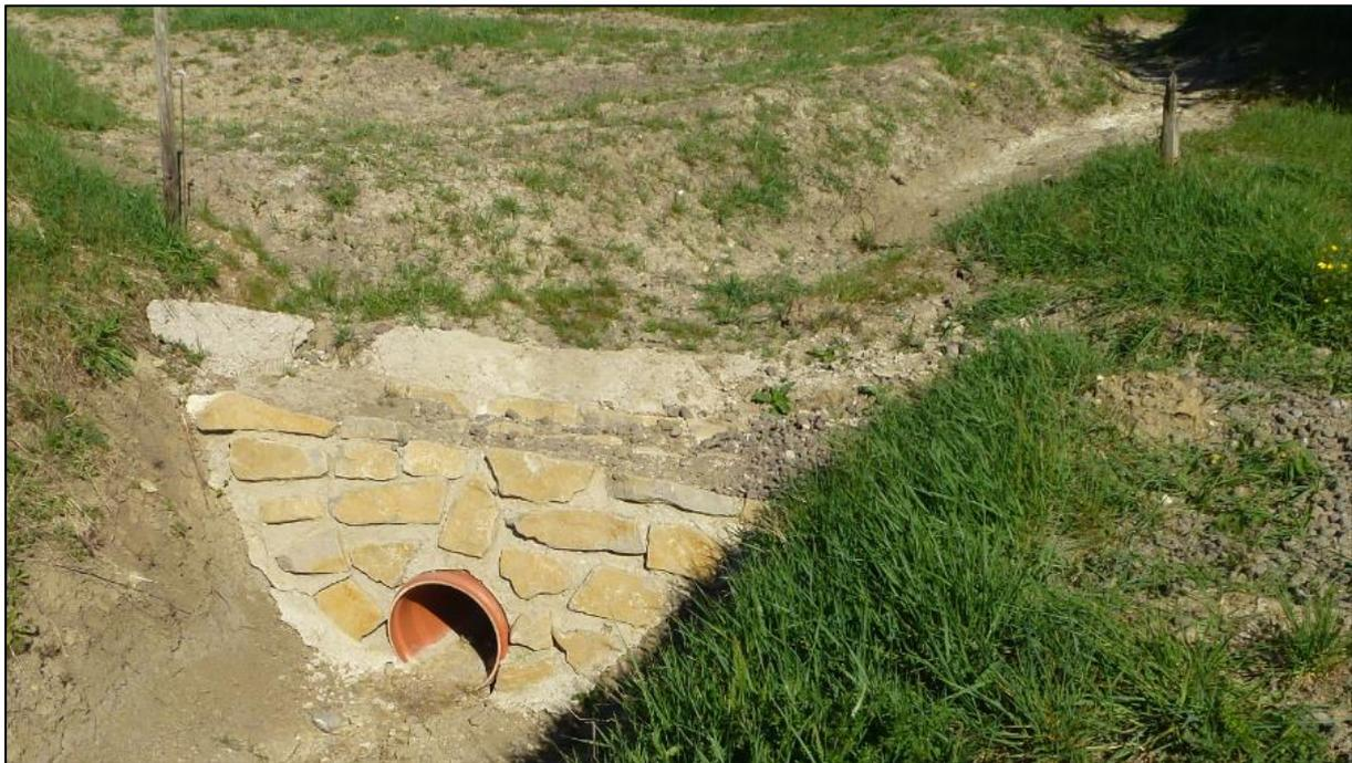
Abbildung 28: Verrohrung im Graben
