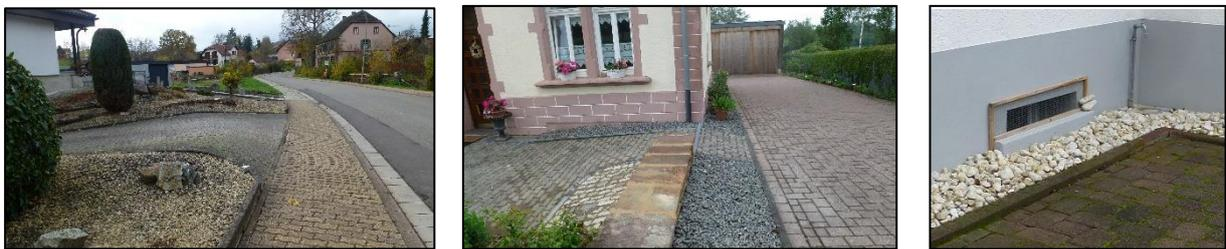
Abbildung 42: Beispiele von Objektschutzmaßnahmen (Überbogen, Geländemodellierungen, Aufkantung am Kellerfenster)
