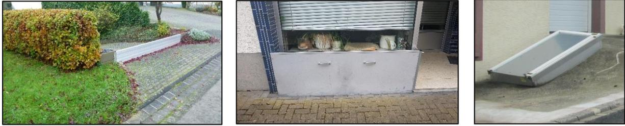
Abbildung 41: Beispiele von Objektschutzmaßnahmen (mobile Steckelemente, Dammbalkensysteme, Abdichtungen)
