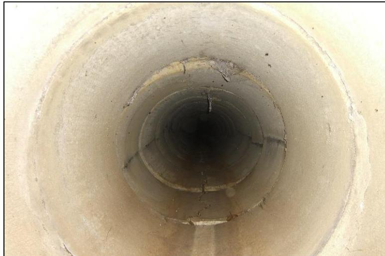
Abbildung 46: Beschädigte Verrohrung
