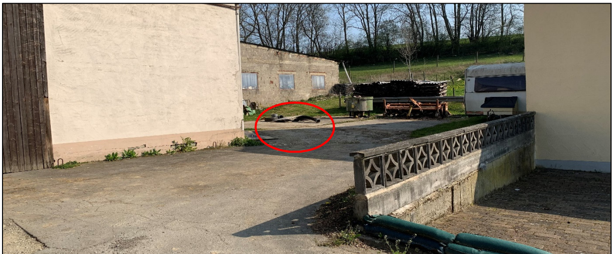
Abbildung 49: Stark von Überflutung gefährdeter Gülletank
