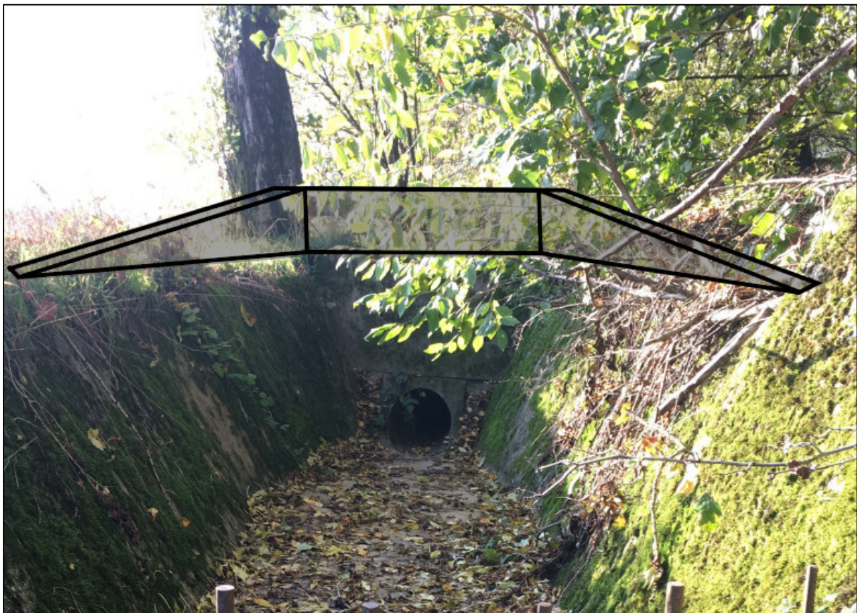
Abbildung 74: Aufmauerung rund um den Einlauf des Tiefbachs
