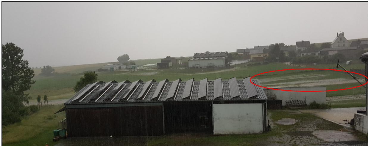
Abbildung 60: Oberflächenabfluss 2018 unterhalb der Schulstraße
