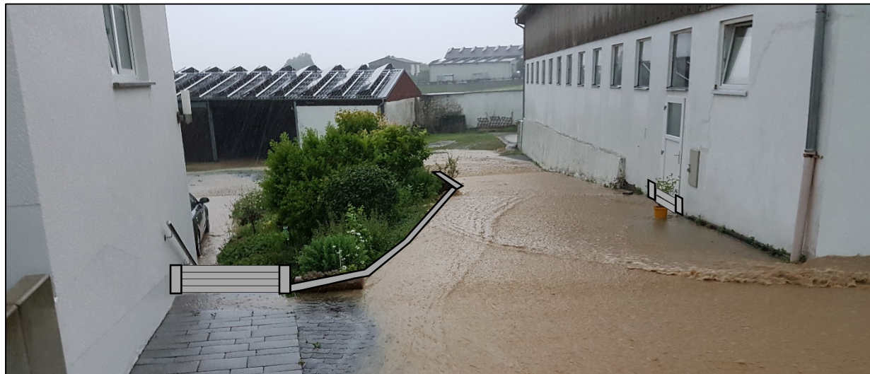
Abbildung 70: Eigenschutzmaßnahmen Gindorfer Straße Hsnr. 14, Bereich Zufahrt
