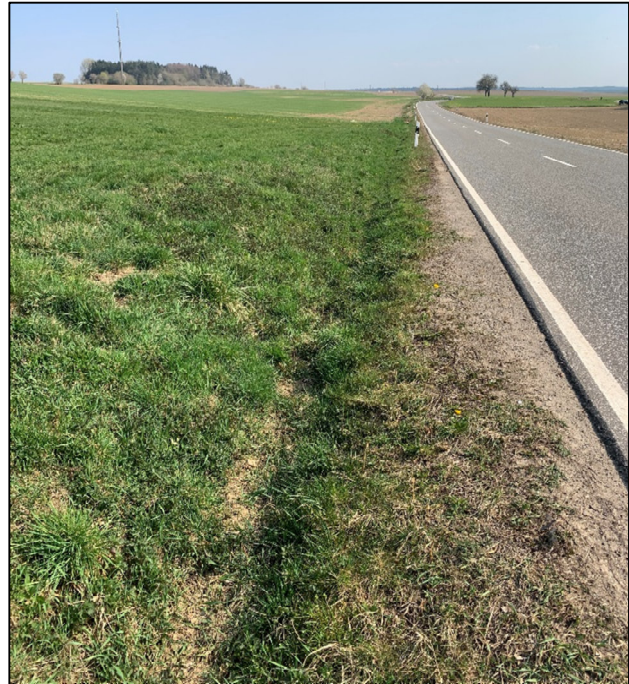
Abbildung 76: Entwässerungsgraben oberhalb der B 257
