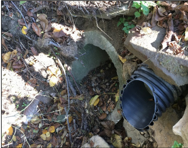
Abbildung 25: Durchlass Gindorfer Straße, Langebach
