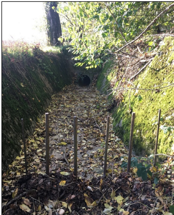
Abbildung 40: Durchlass Graben "Tiefbach" mit vorgeschaltetem „Rechen“
