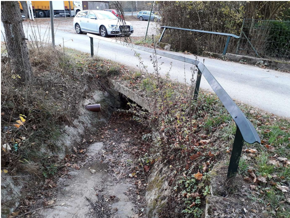
Abbildung 10: Durchlass Rasenbach "Im Mörchen"
