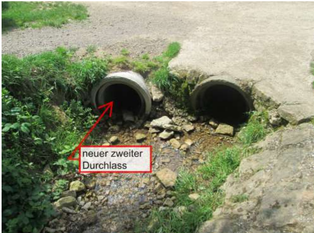
Abbildung 53: Durchlass Bauerbach auf dem Campingplatz
