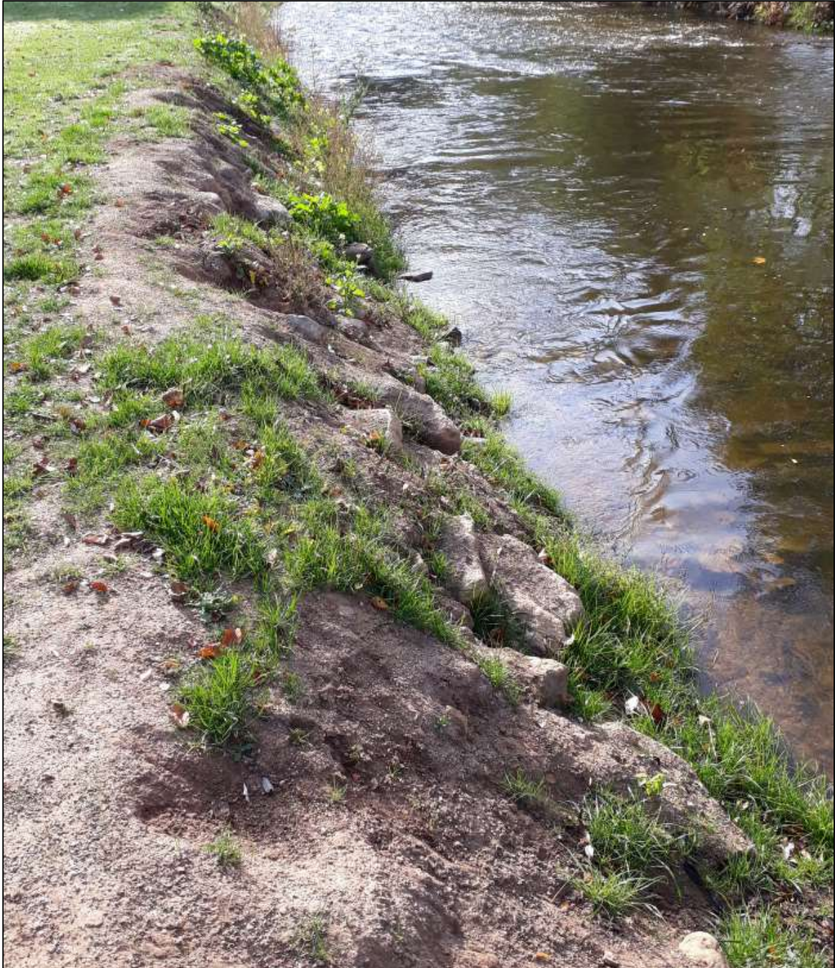
Abbildung 32: Auffüllungen an der Prüm über dem Hauptkanal
