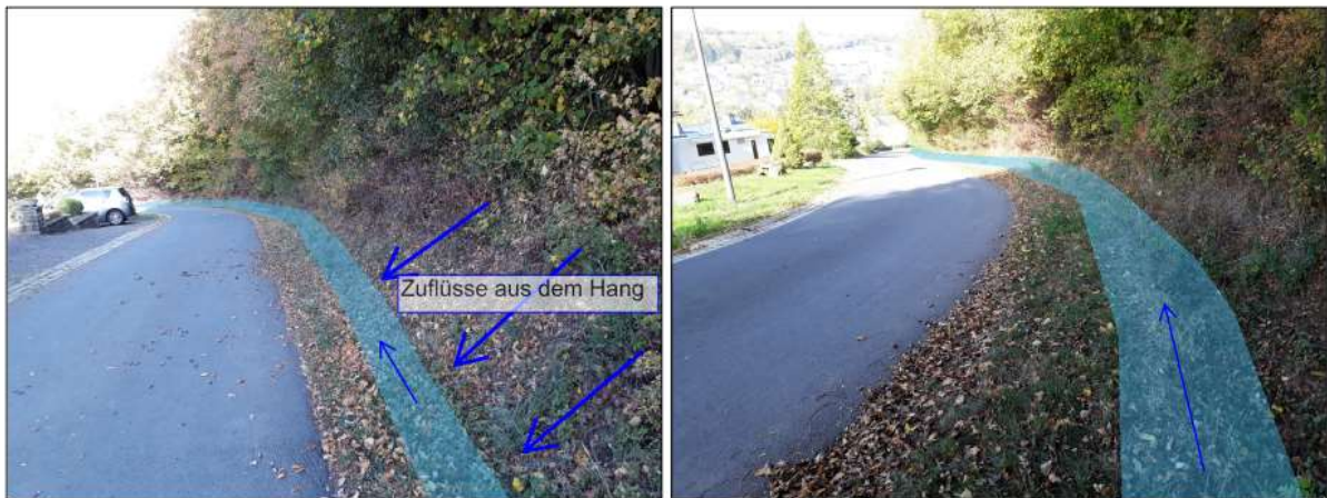
Abbildung 47: Visualisierung Neuprofilierung Graben Hangseite "Kuhweg"
