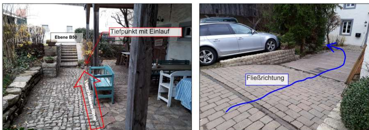
Abbildung 22: Entwässerungssituation "Neuerburger Str. 5"
