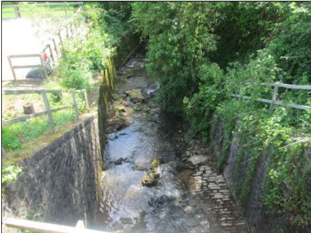
Abbildung 12: Nierbach vom Durchlass B50 stromabwärts gesehen
