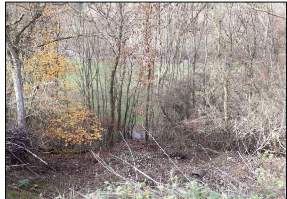
Abbildung 37: Blick von Rutschstelle auf Radweg
