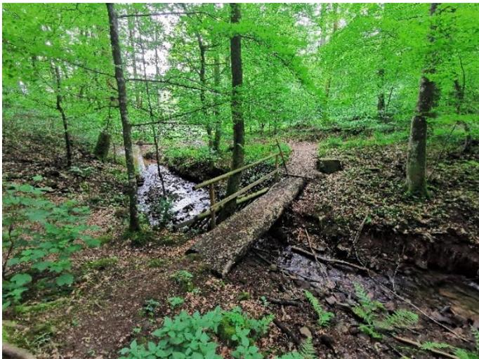
Abbildung 40: Fußgängerbrücke mit vorgelagertem Treibgutrechen im Oberkailer Bach vor der Mündung in den Kailbach.
