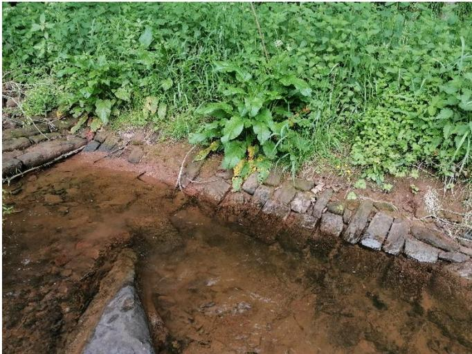
Abbildung 37: Sohlbefestigung des Kailbaches im Oberwasser der bebauten Ortslage von Oberkail.
