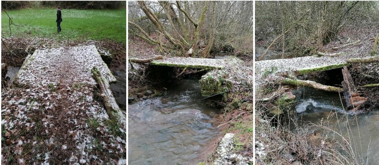
Abbildung 30: Marodes Brückenbauwerk als Abflusshindernis im Gewässerverlauf.
