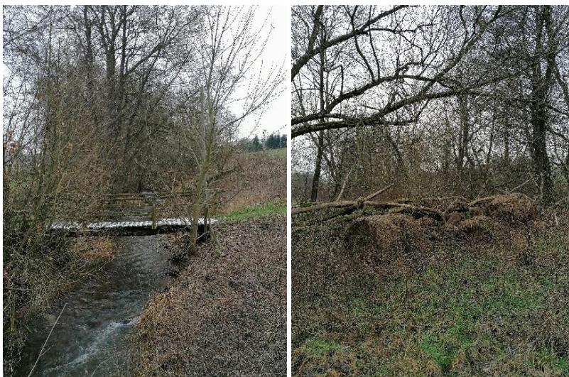
Abbildung 31: Brückenbauwerk als Abflusshindernis im Gewässerverlauf und Lagerung von Heu-/ Strohballen im Hochwasserabflussbereich.
