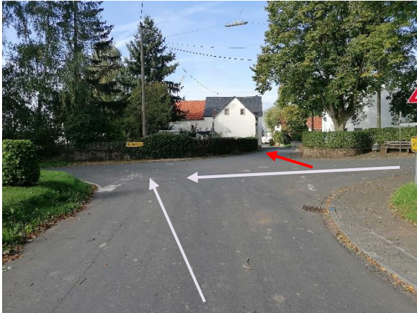
Abbildung 16: Oberflächenabfluss im Kreuzungsbereich Steinborner Straße, Dorfstraße, Seinsfelder Straße und Kyllburger Straße.
