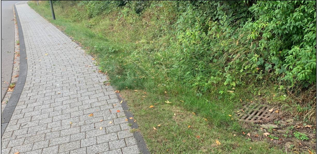
**Abbildung 34: Einlaufbauwerk am Ende des Entwässerungsgrabens oberhalb der Bebauung Talstraße Nr. 10**
