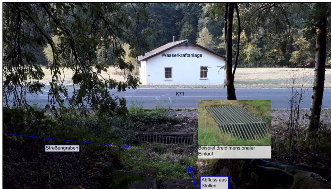
Abbildung 20: Visualisierung Verbesserung Einlaufsituation Abflüsse aus Stollen
