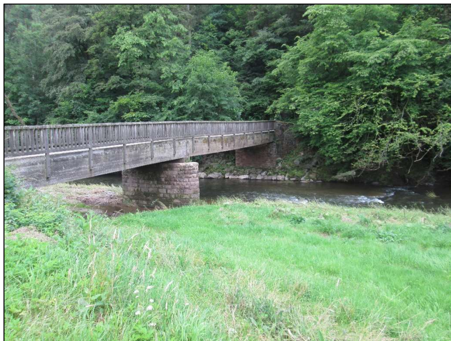
Abbildung 10: Prümbrücke in Hamm
