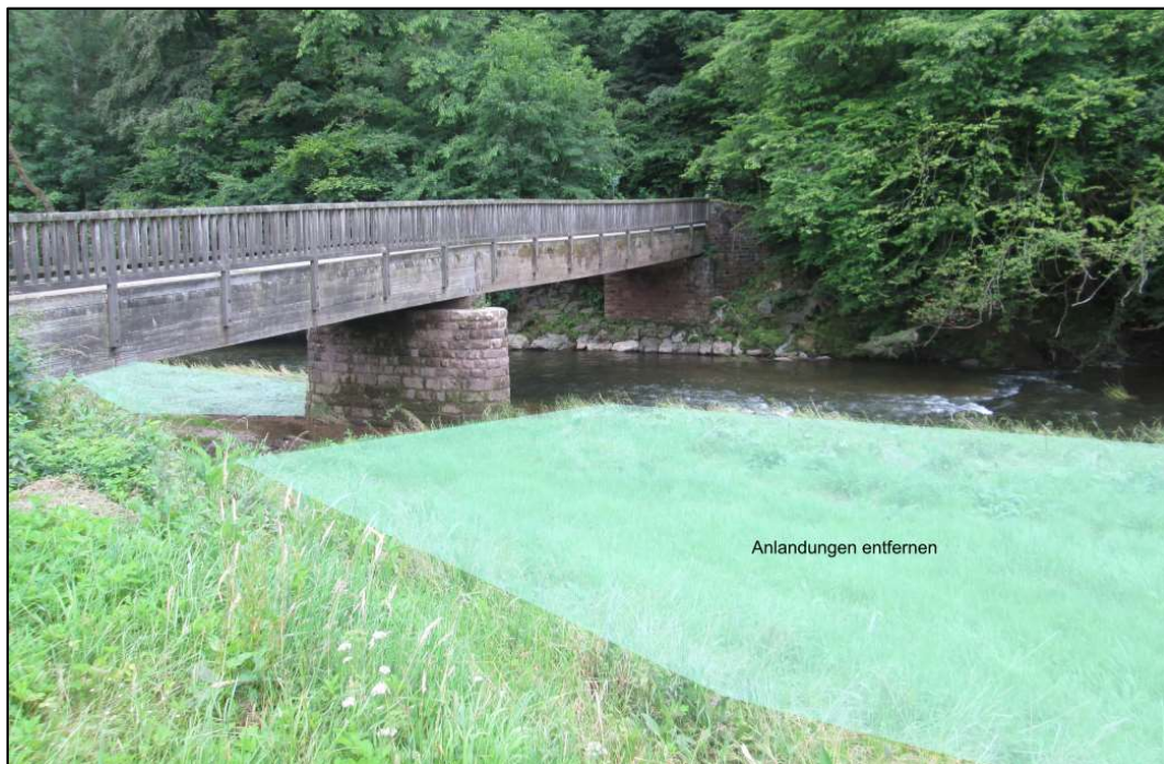
Abbildung 15: Bereich Abtrag Anlandungen vor Prümbrücke
