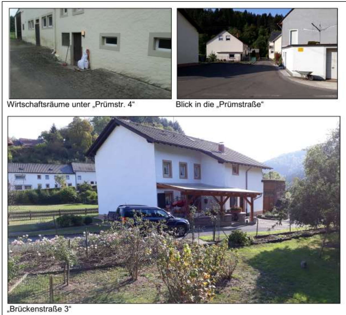
Abbildung 8: Objekte im Überschwemmungsbereich der Prüm
