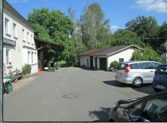
Hauptstraße 4, vom Hochwasser betroffen
