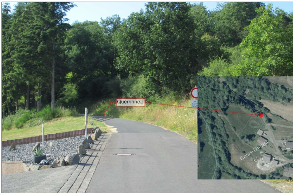
Abbildung 19: Querrinne am Wirtschaftsweg vor Bebauung
