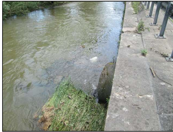
Abbildung 21: Einmündung Echersbach in Prüm
