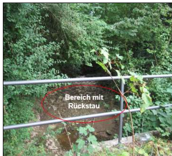
Abbildung 18: Heldengraben am Durchlass 2 in Fließrichtung
