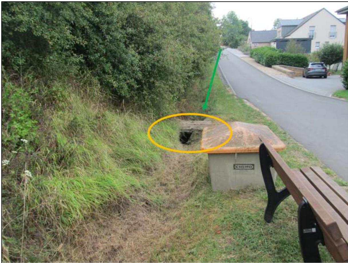
Abbildung 14: Einlauf und Straße "Linsenberg"
