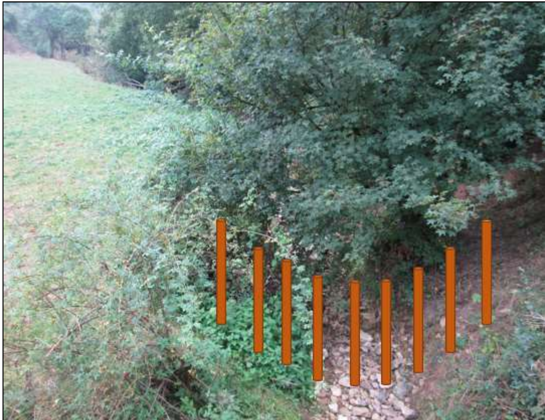
Abbildung 32: Geröllfang Heldengraben vor Durchlass 2
