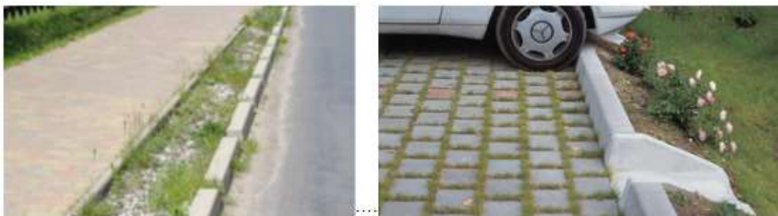
Abbildung 29: Ausführungsbeispiele geöffnete Bordsteine (Quelle: Hansestadt Hamburg)
