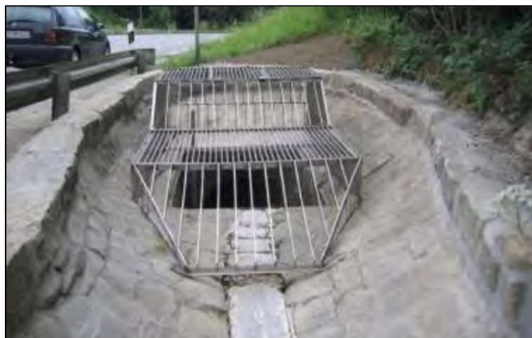
Abbildung 30: Ausführungsbeispiel Einlaufbauwerk (Quelle: Stadt Hagen)
