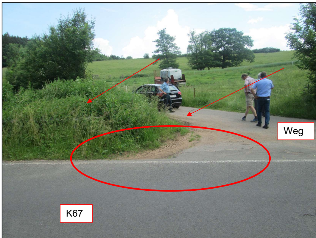
Abbildung 17: Abflusssituation am Durchlass 1 „In Löschem“
