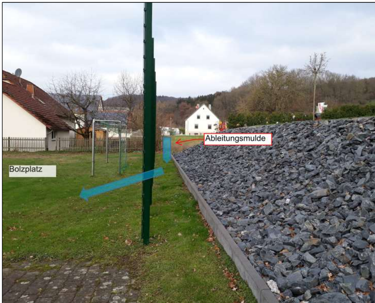
Abbildung 31: Lenkung Abflüsse freie Baugrundstücke
