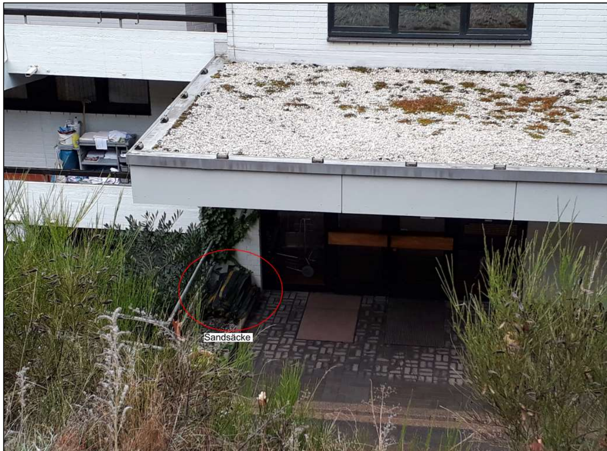
Abbildung 34: gelagerte Sandsäcke vor Eingangsbereich Appartementhotel
