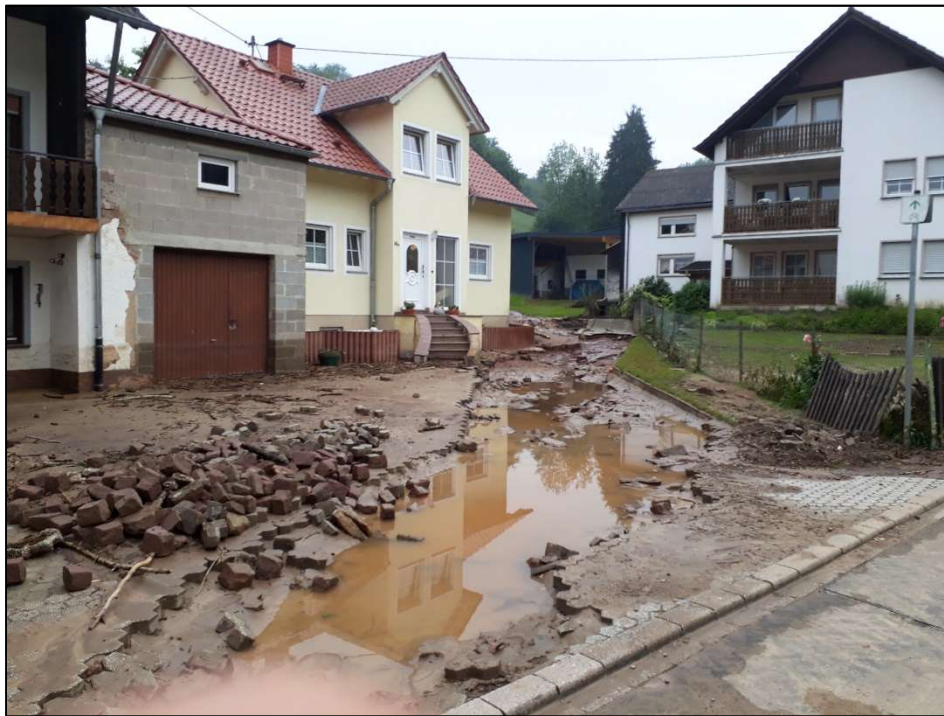
Abbildung 12: Schäden am Objekt "Talstr. 14a"
