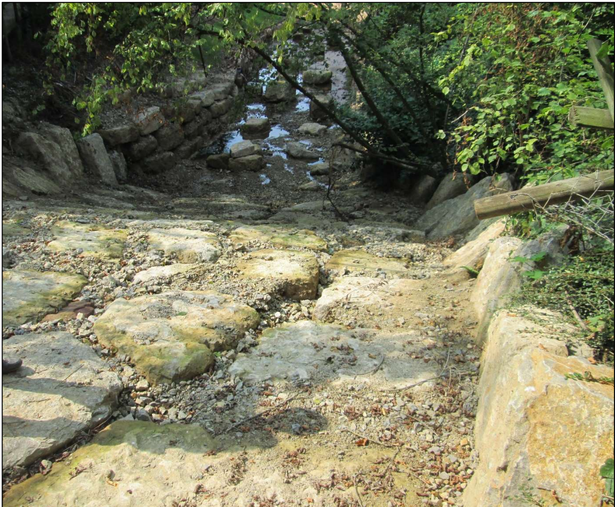
Abbildung 18: Wehranlage im Kannenbach nach Sofortmaßnahmen
