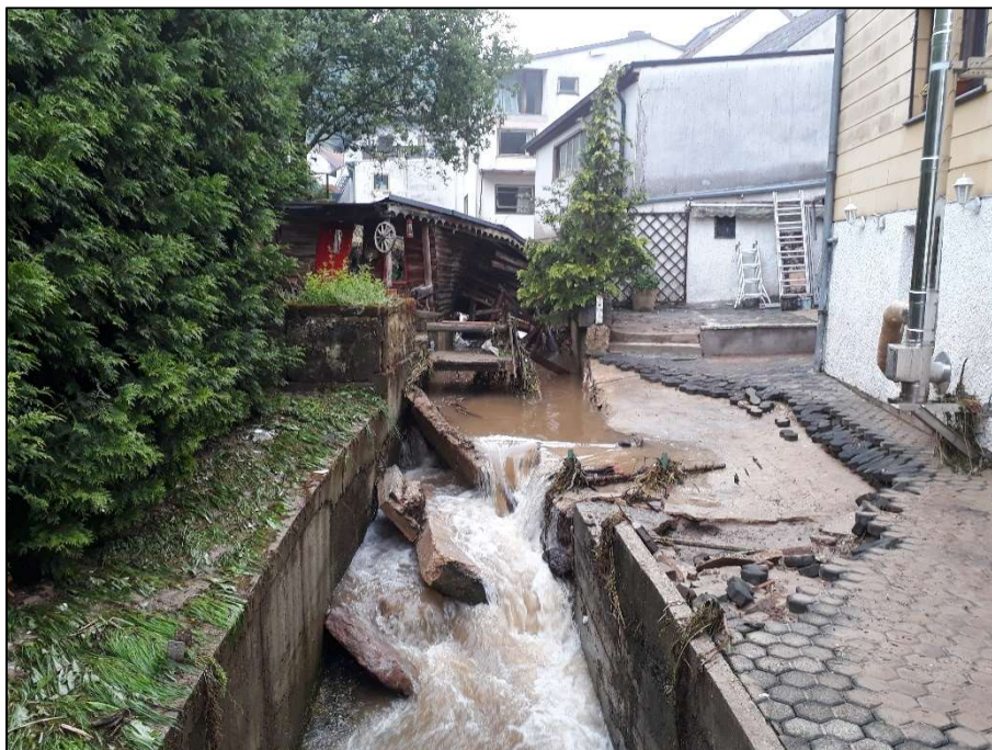
Abbildung 11: Schäden am Kannenbach Höhe "Mühlenstr. 6"
