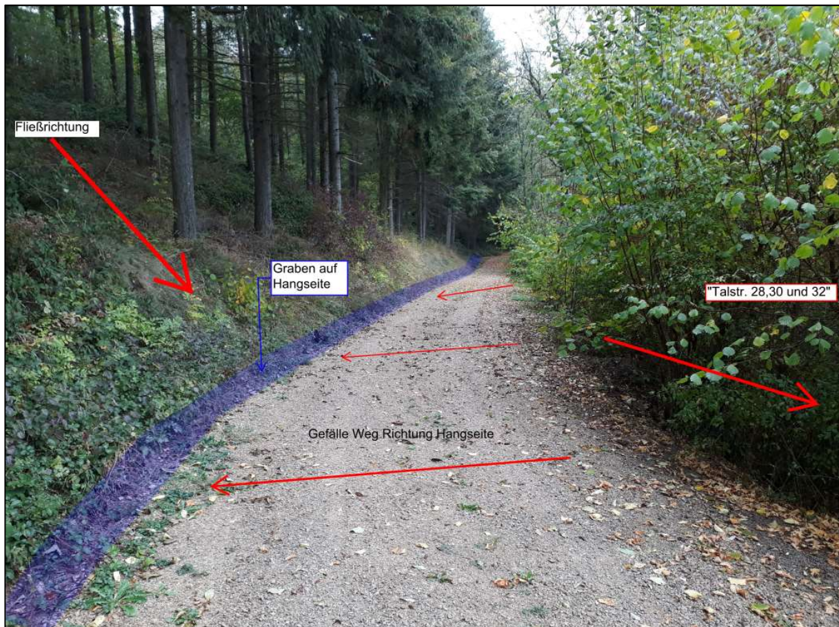
Abbildung 54: Maßnahmenvorschläge erster Wirtschaftsweg oberhalb "Talstr. 28, 30 und 32"
