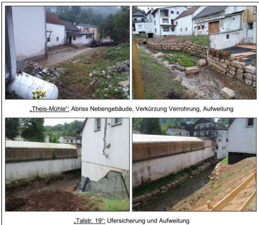
Abbildung 28: Sofortmaßnahmen am Kannenbach
