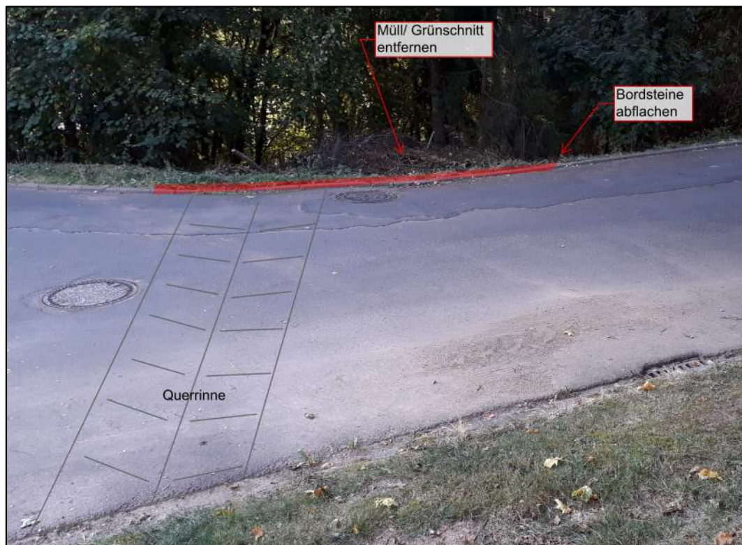
Abbildung 57: Detail Lenkung Abflüsse zur Weiterführung Tiefenlinie
