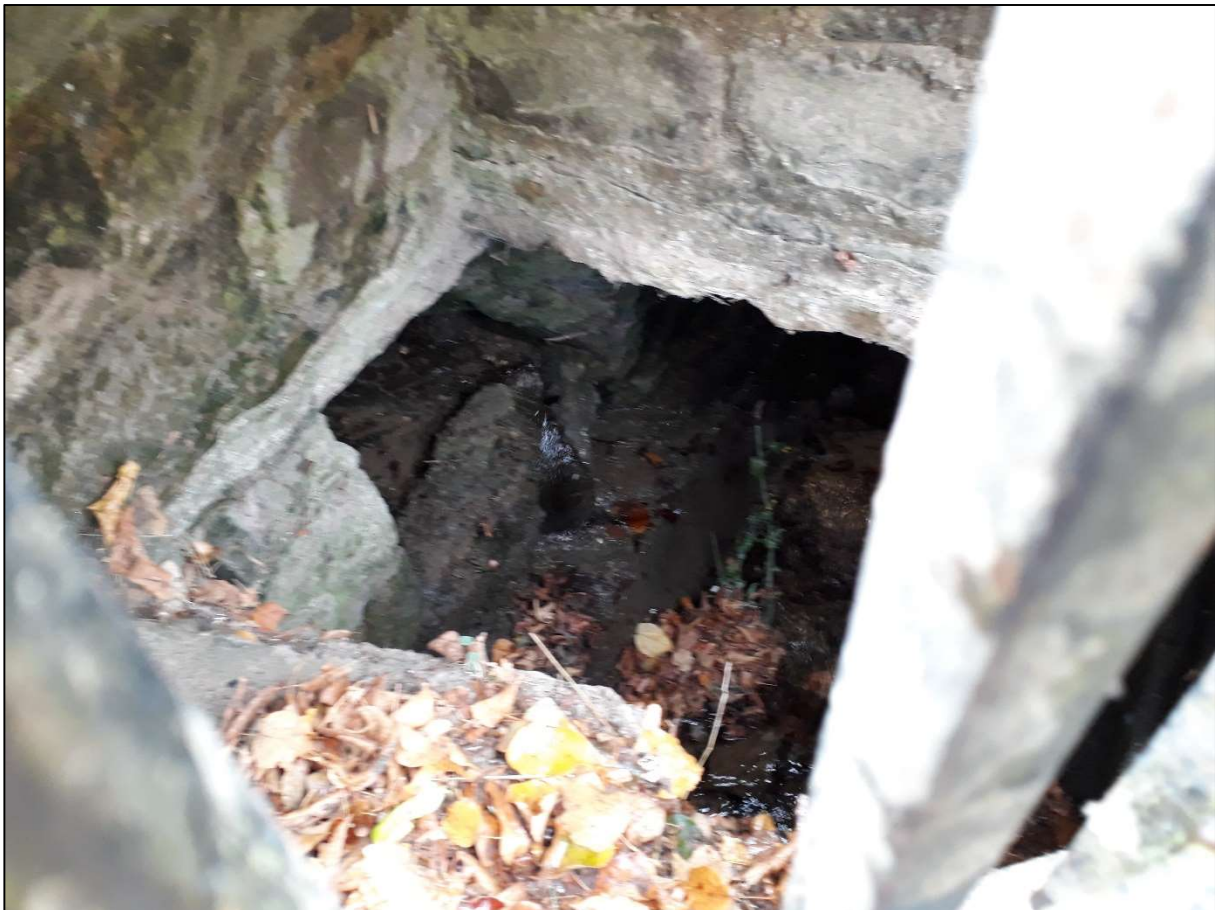
Abbildung 46: Blick in den Haubenkanal unter der "Talstraße"
