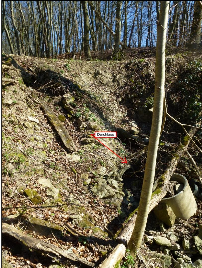
Abbildung 50: Defekter Durchlass am 25.03.2020
