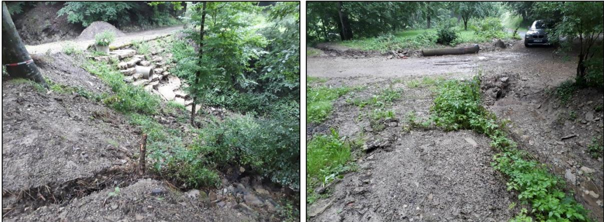
Abbildung 51: Ansicht neuer Durchlass und Rinne aus dem Seitenzufluss sowie Situation Seitenzufluss am 28.07.2021
