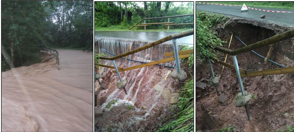
Abbildung 54: Erdrutsch im Bereich der Brücke
