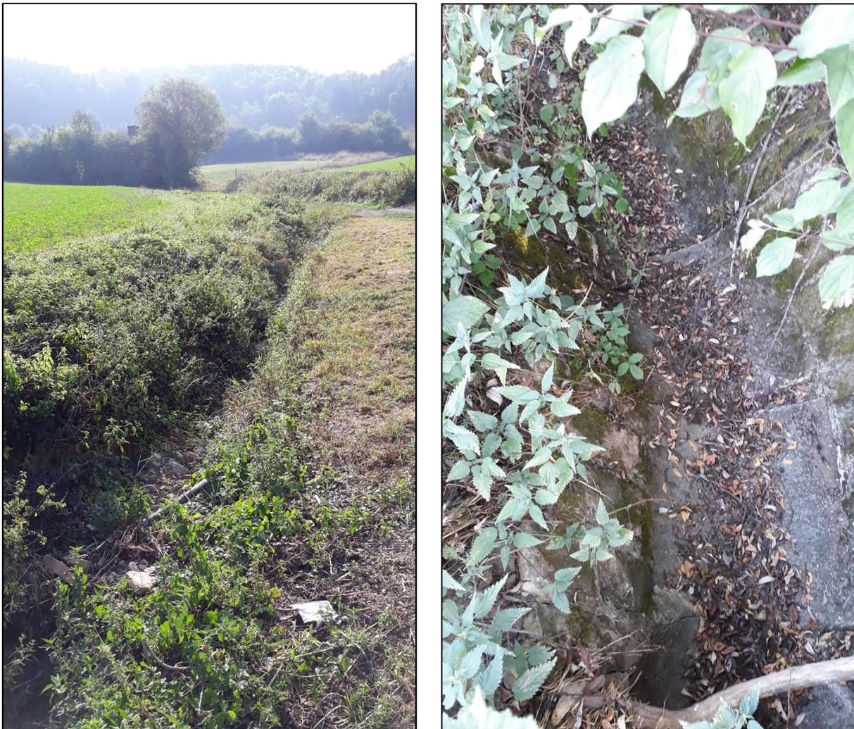
Abbildung 50: Bach von der Höhe, links Abschnitt mit Sohlablagerungen, rechts Ausbau mit Halbschalen
