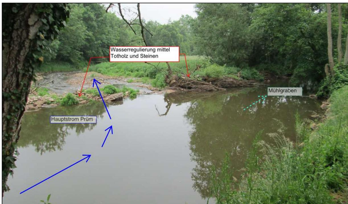
Abbildung 32: Regulierung Wasserstand Abzweig Mühlgraben
