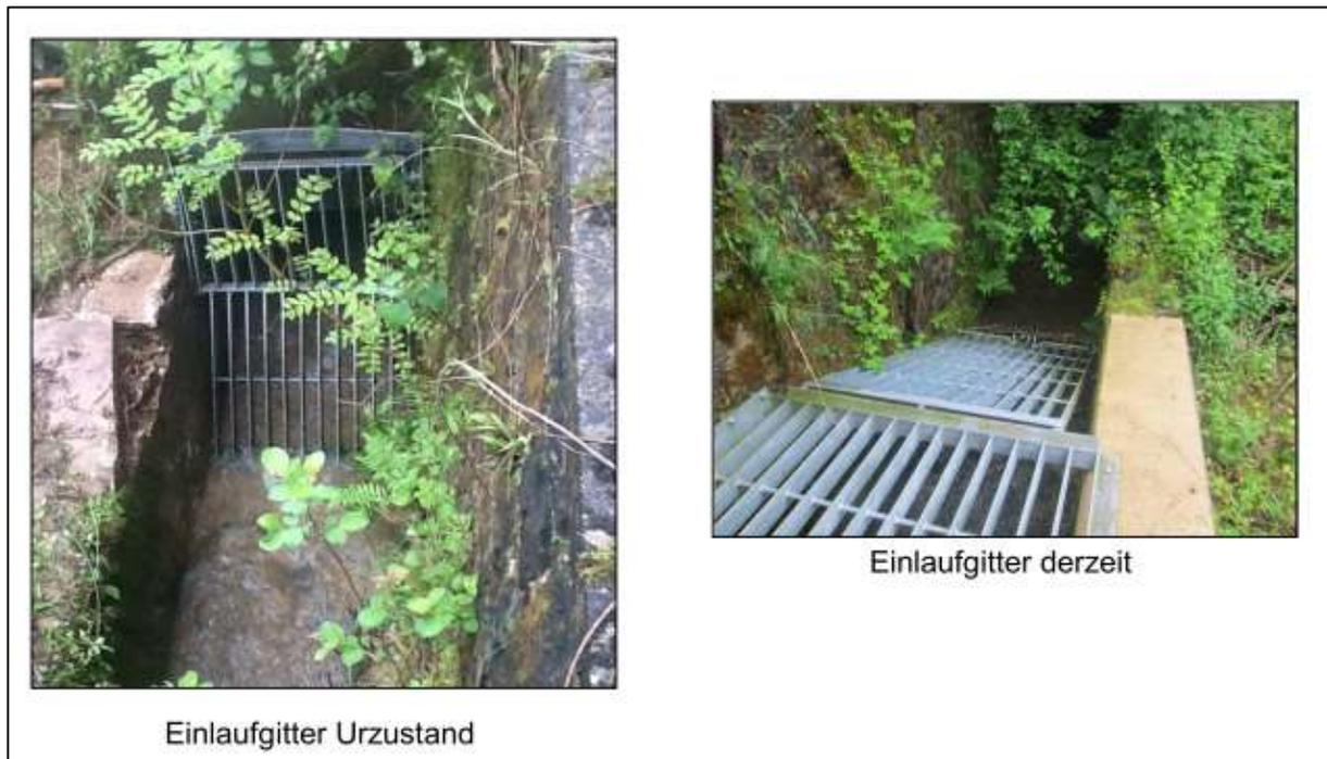
Abbildung 12: Einläufe am Schrödersgraben
