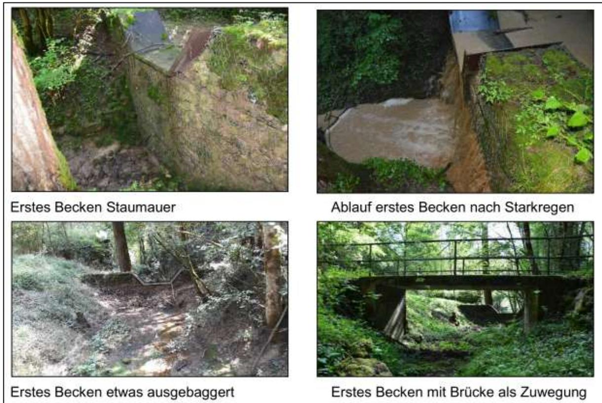
Abbildung 15: Zustand erstes Rückhaltebecken
