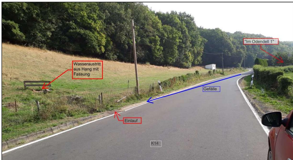
Abbildung 11: Entwässerungssituation "Im Odendell"
